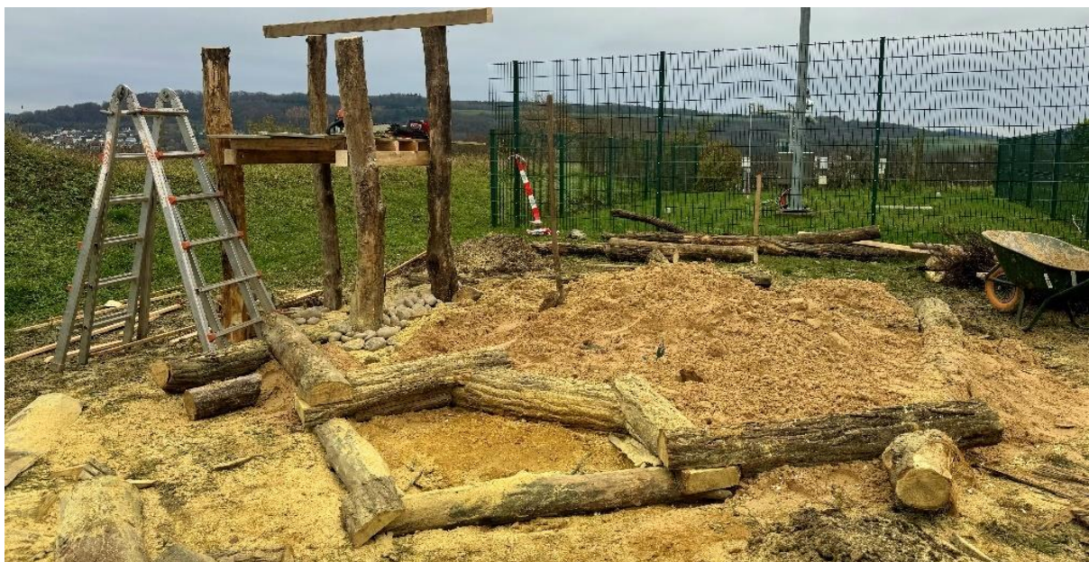
Anlage einer bestäuberfreundlichen Anlage in Grevenmacher.
